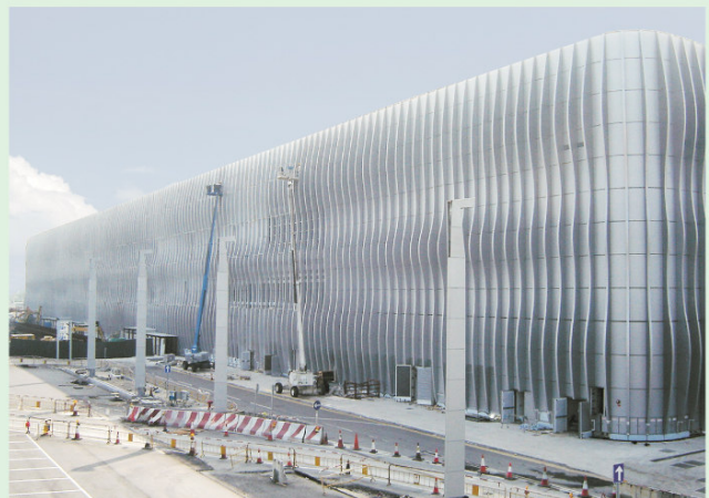
外牆正面層—單一系統的雙層鋁幕牆，牆身的外觀設計非常細緻。
