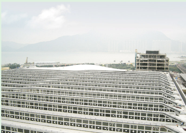
主屋頂—辦理登機手續大堂的主屋頂由多層膜片屋頂系統、鋼鐵桁架和遮擋天花組成。
