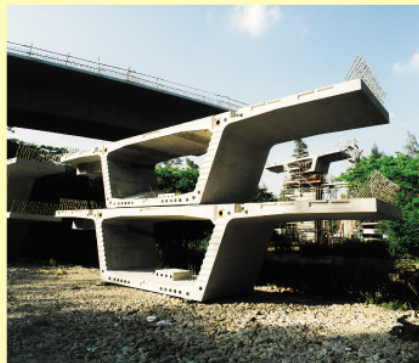
橋身的預制組件。 The pre-cast segment of the viaduct.
