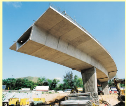
興建中的高架橋橋身。 The viaduct under construction.
