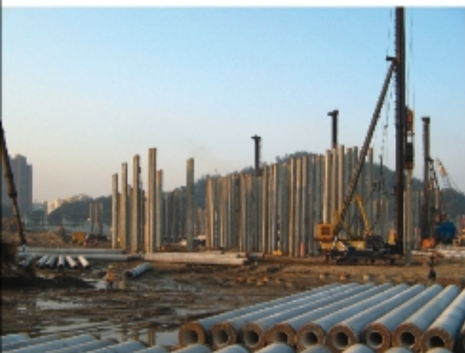
2005年1月成功獲得項目的兩項地基工程。 Foundations contract awarded in January 2005.
