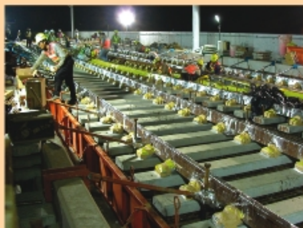
軌道混凝土澆置預備工作。 "RHEDA" track pre-concreting setup.
